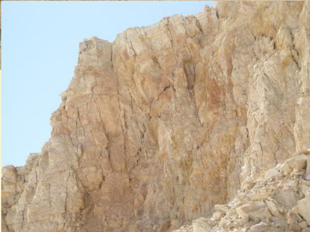
1) Controlar con el diseño de las voladuras la **pendiente del talud entre los 75° y 80°**, tal como se hace hasta el momento (la señal es que quedan marcadas las **cañas de los barrenos**). Por debajo de dichos ángulos pueden aparecer más bloques en la cara de banco, propiciando su vuelco, y por encima de esos ángulos aumenta el peso de las cuñas.
