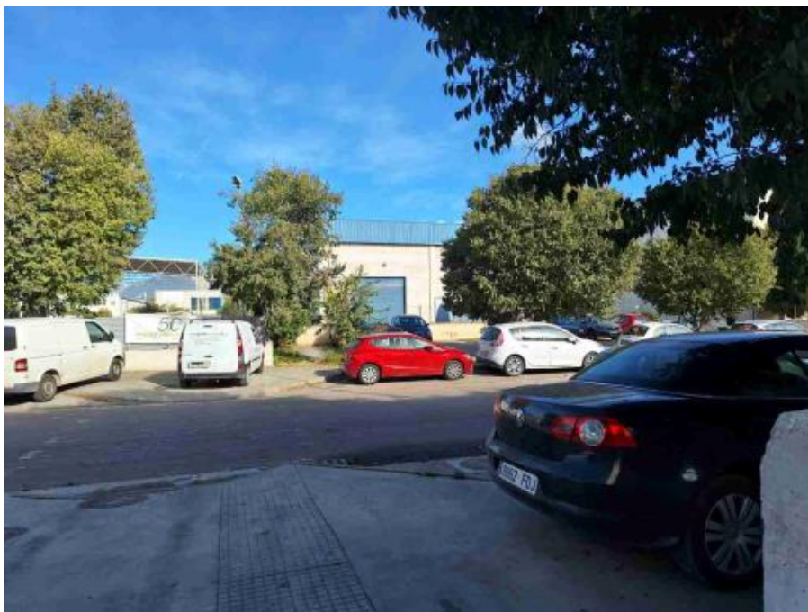
Ilustración 24.- Vista de la planta desde la acera enfrente. No se ve la totalidad de la fachada. La zona ampliada será ocultada por los árboles y la fachada.
