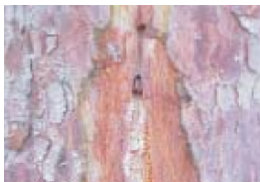
FOTO 12: Galeria amb segregació de reina
