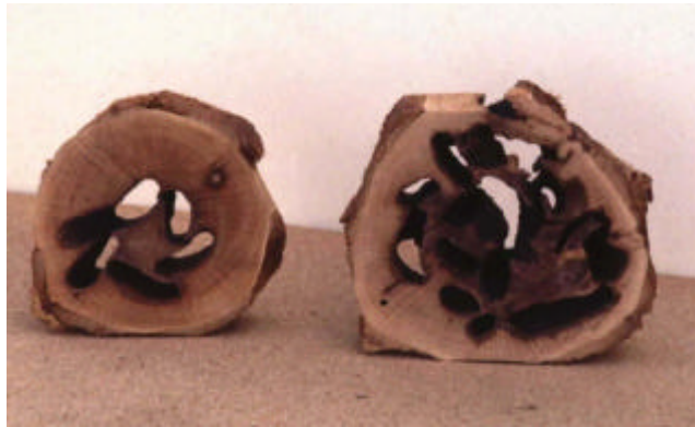
Figura 4.- Daños del Cerambyx en la madera.
