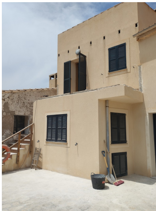
Obres reparació façana 6
