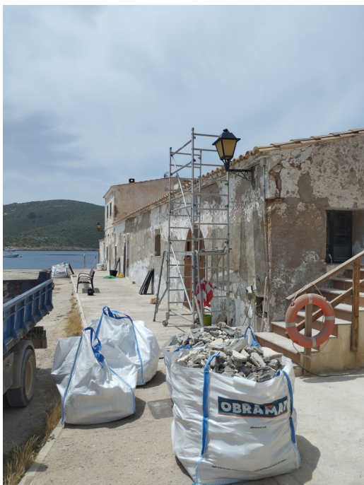
Obres reparació façanes 1-5
