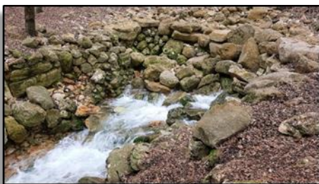
Detall de la paret de blocs rocosos executada en una de les surgències principals.
