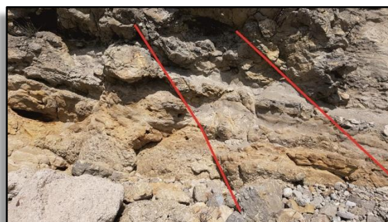
Fallas que atraviesan los sedimentos.
