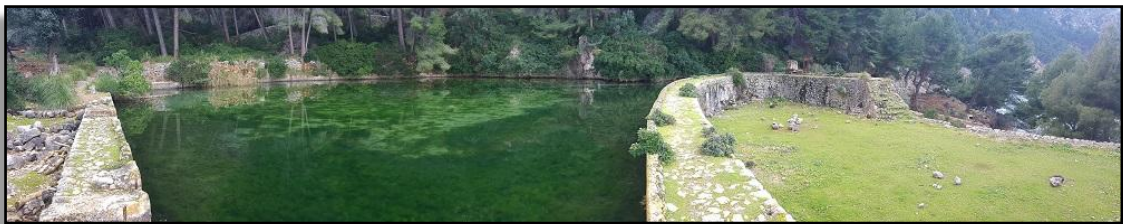
Estany enorme d'aigua (safareig) per al subministrament de la central hidroelèctrica
