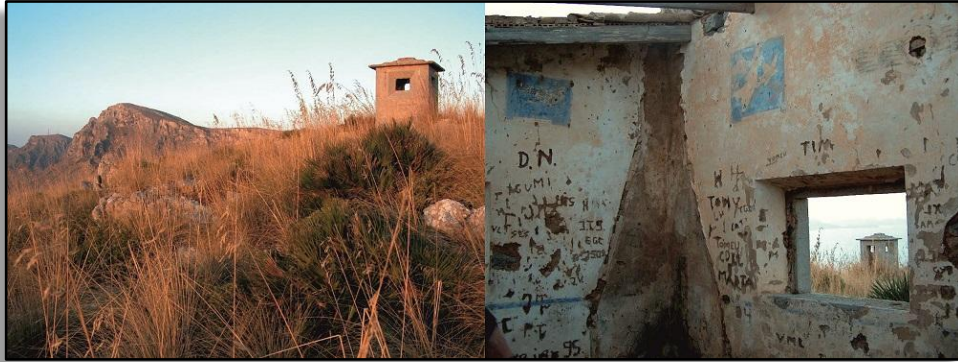
Garita i sala principal de la caserna. Observeu els avions pintats a les parets.
