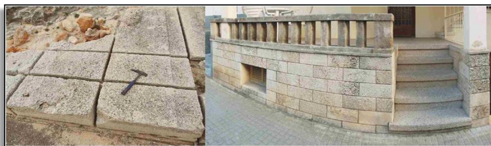
Detall dels blocs de lumaquel·la existents a la pedrera i a un habitatge de s'Arenal
