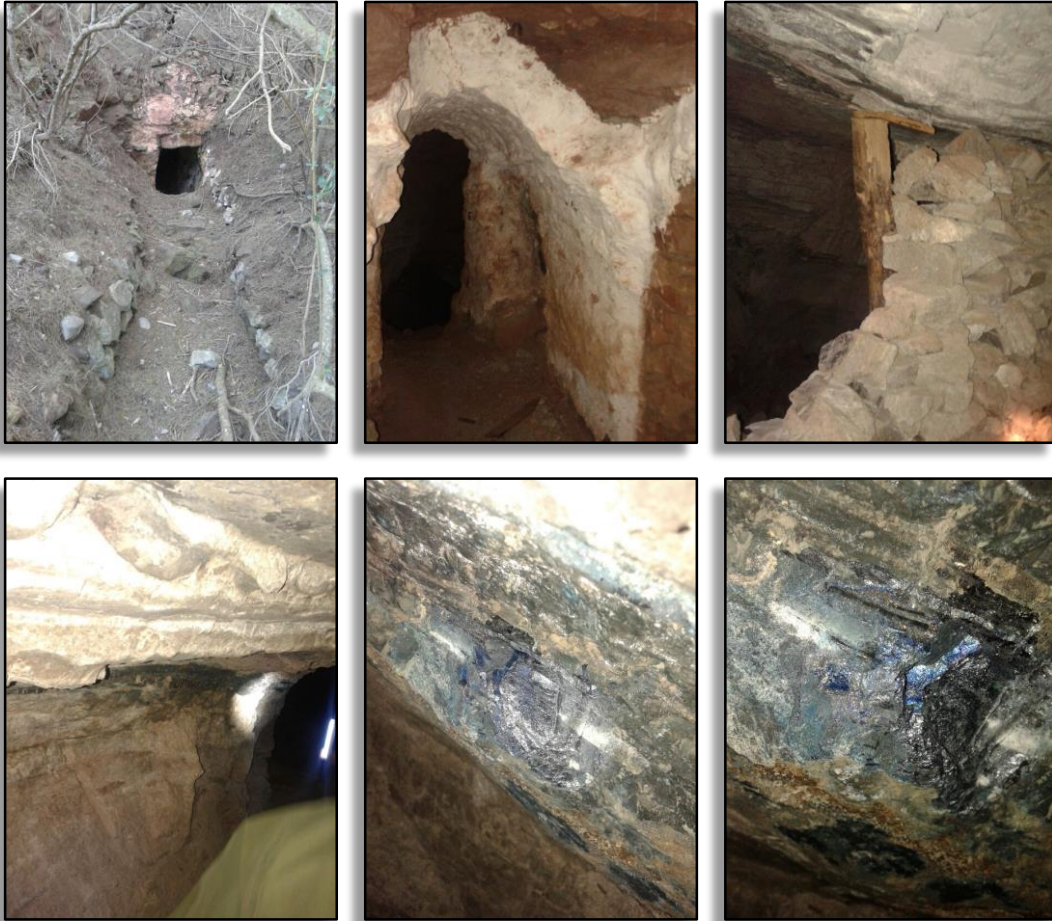
Acceso principal de "la Rubia", arco mampostado blanqueado y restos de apuntalamientos en el interior de la mina (arriba); y nivel de carbón (lignito) con calcosina (de color negro – gris plomo) y con presencia de minerales alterados (azurita, de color azul) (abajo).
