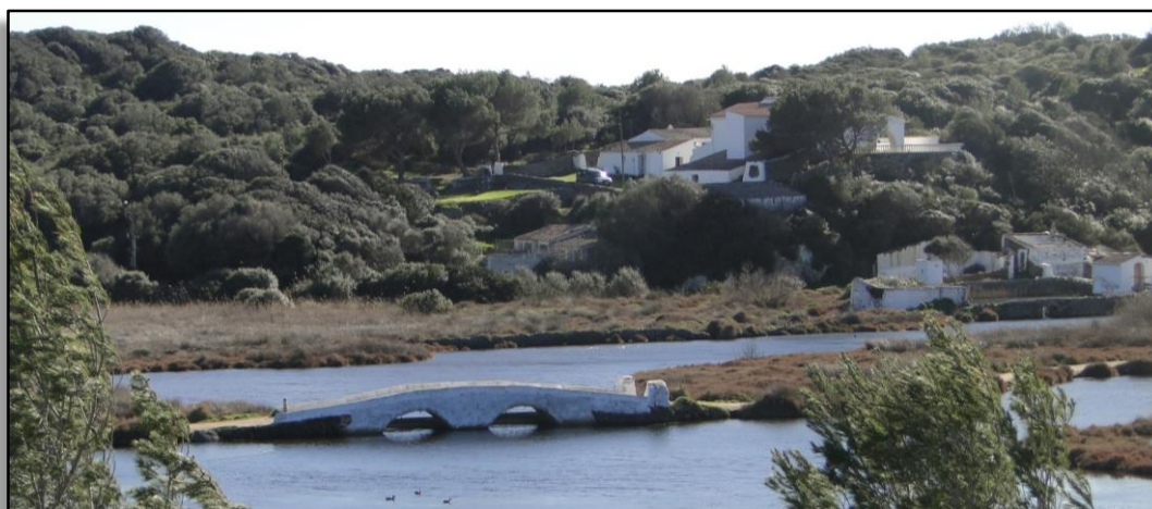
Puente con las compuertas utilizadas para regular el flujo de agua entre la albufera y el mar. Tradicionalmente esta regulación tenía finalidades pesqueras, pero actualmente la gestión está enfocada a la conservación de la laguna.
