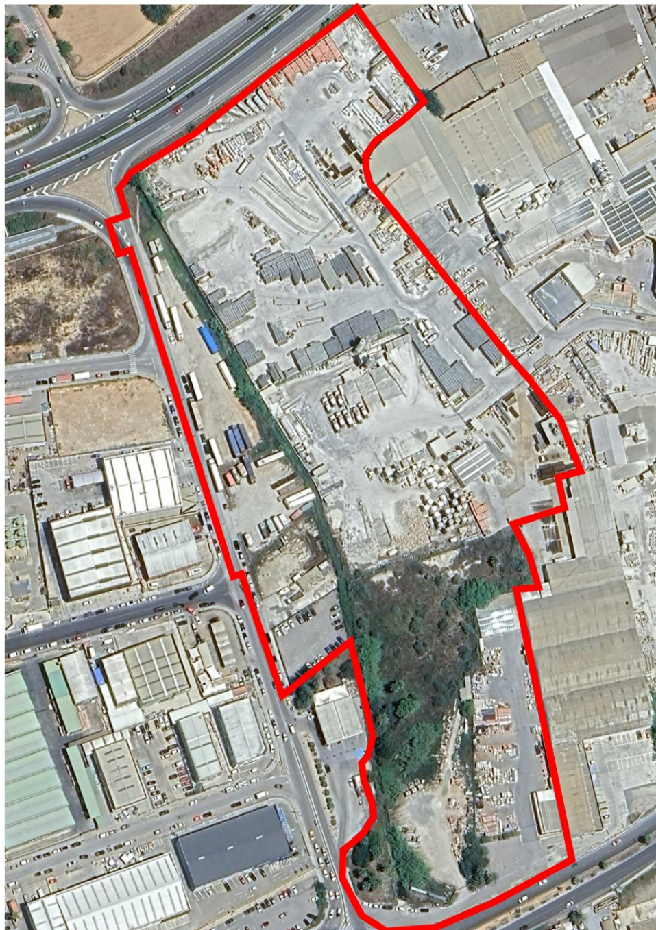
Ámbito de los terrenos de la UA 05 sobre fotografía aérea
