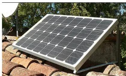
2. La subestructura que sirve de soporte a la instalación no puede sobresalir fuera de los límites de los paneles.
