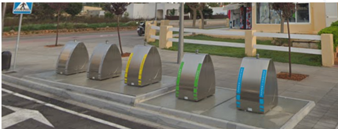
Figura 7. Isla de contenedores soterrada al C/ Joaquin Gadea. Font: Fuente: Street View de Google (captura imagen nov. 2018).
