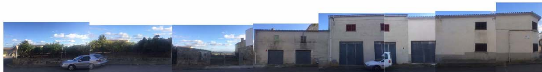
Vista actual de la fachada de la Calle de Na Pelada.
