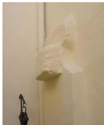
Arranque arco superpuesto a la cisterna.
