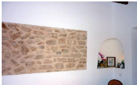
Mampostería en verde común aparejo "opus spicatum"
