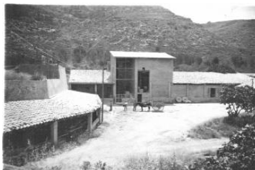
Vista general cementera años 1940
