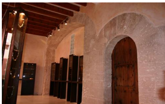
Zona 1: arcos interior
