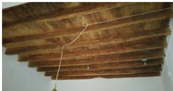
Zona 1: forjado madera
