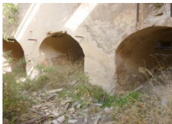
Zona descarga cemento mallorquín
