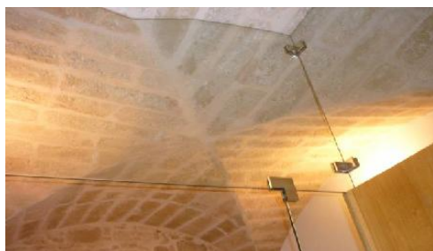
Bóveda de arista.
