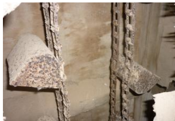
Catalfos de elevación en el depósito
