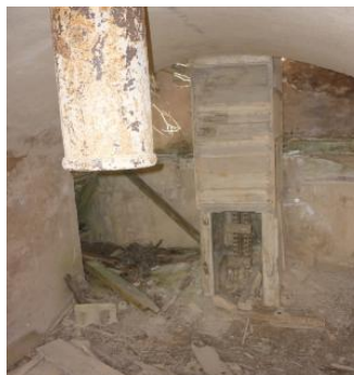
Zona descarga cemento mallorquín
