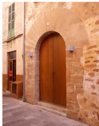
Zona 1: puerta de entrada
