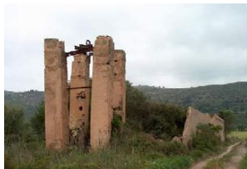
Pozo de acceso a la mina "Verge del Puig" 1890
