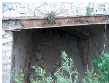
Tolva de salida de la piedra cocida del horno
