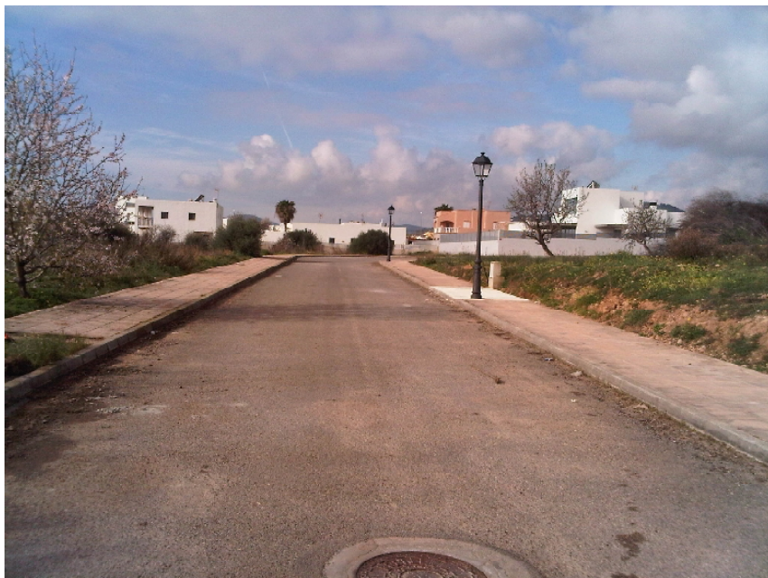
Primer tramo de la CALLE A orientación Este-Oeste . linde Sur manzana 2.1.
