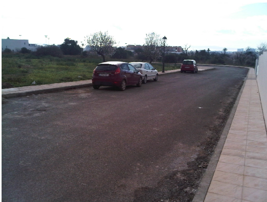
Segundo tramo de la CALLE A, orientación Norte-Sur . linde OESTE manzana 2.1.
