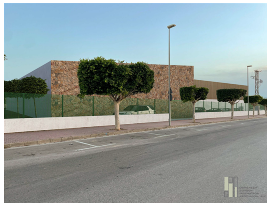
Infografia 1. Façanes a la carretera de S'Estanyol i a la parcel·la de l'actual camp de futbol.
