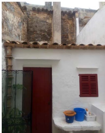
Zona 2: construccions al pati
