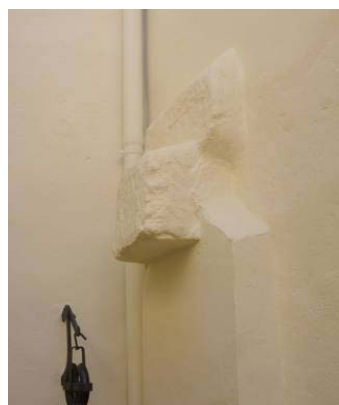
Arrencada arc superposat a la cisterna.
