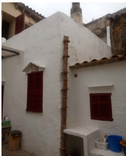
Zona 2: construccions al pati
