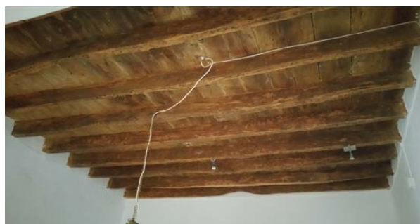
Zona 1: forjat fusta
