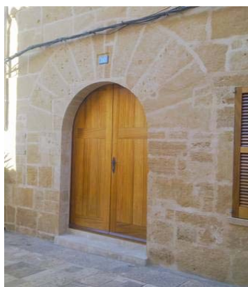
Portal de mig punt adovellat.
