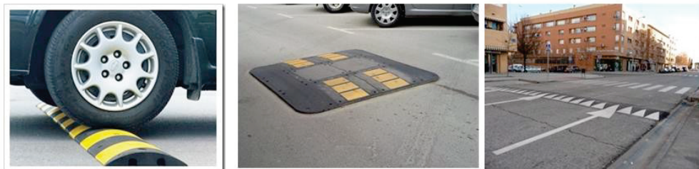
Fig. 62. Elementos reductores de velocidad
