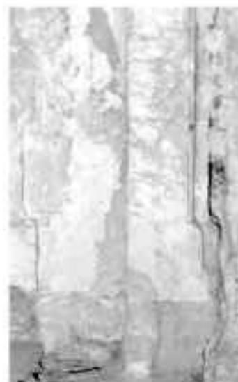
Capilla de Sant Antoni, muro este con la indicación de las fases constructivas. Al extremo la pilastra que oculta las anteriores góticas.
