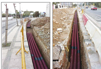
FOTOGRAFÍAS EJECUCIÓN SOTERRAMIENTO DE MEDIA TENSIÓN
