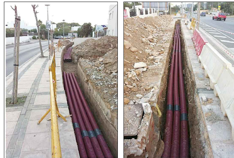
FOTOGRAFÍAS EJECUCIÓN SOTERRAMIENTO DE MEDIA TENSIÓN
