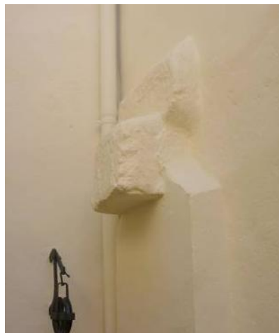
Arranque arco superpuesto a la cisterna.
